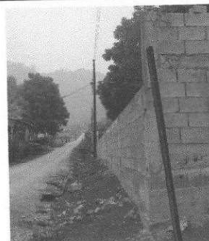
Foto 2: Se observa el muro perimetral frontal de la escuela terminada
