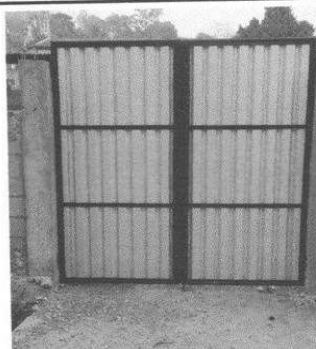
Foto 4: Se observa el portón de la entrada principal instalada.
